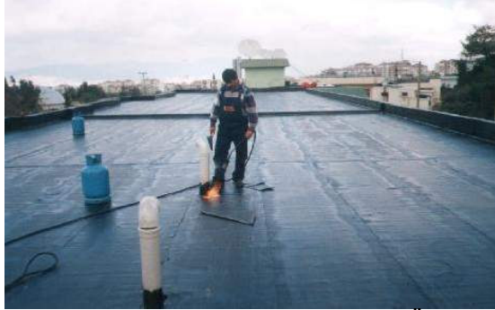
Resim 2: Teras Çatılarda Su Yalıtımı Örneği
