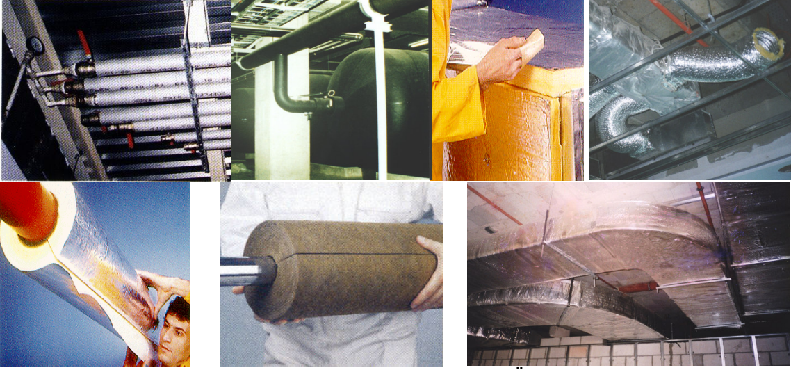
Resim 5: Tesisat Yalıtımı Uygulama Örnekleri
